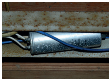
Ældre kondensatorer indeholder ofte PCB.
