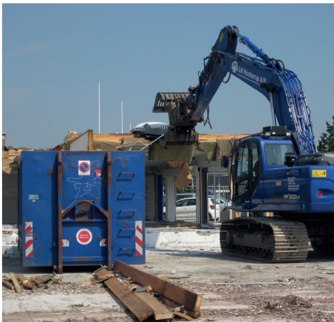
Nedrivning hvor affaldet sorteres umiddelbart.
